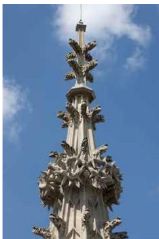
La tourelle nord avec une couronne d'épine
